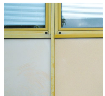
GEREINIGTE MUSTERFLÄCHE (PULVERLACK) MIT KONSERVIERUNG
