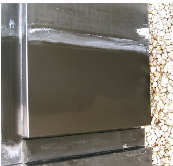
ENTFERNUNG EINES POLYACRYLAT AUF EINER ELOXIERTEN FLÄCHE
